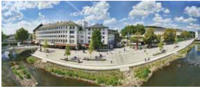
Neue Treppenanlage am Siegufer
