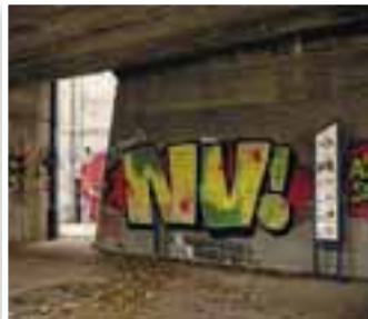
HTS-Rampe beim Bunker Eintracht
