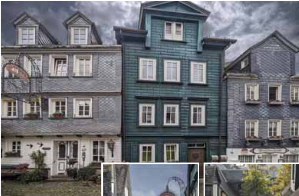
Fassaden in der Unteren Metzgerstrasse
